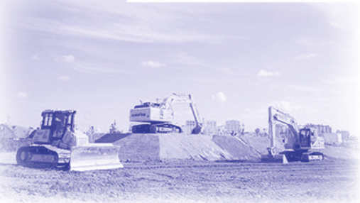
2015 Beginn von „Smart Construction“ Intelligente Lösungen für Baustellen
